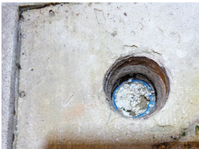
3 | Entnahme von Bohrkernen aus Estrichdämmschicht
