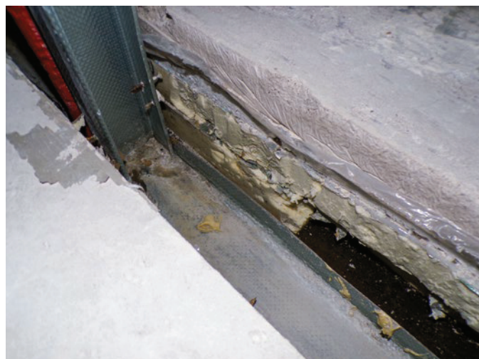
4 | Rückbau des betroffenen Bereichs des Trockbaus
